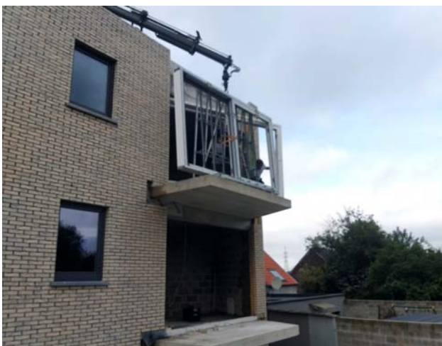
POSE DE CHEVALET POUR CHASSIS
