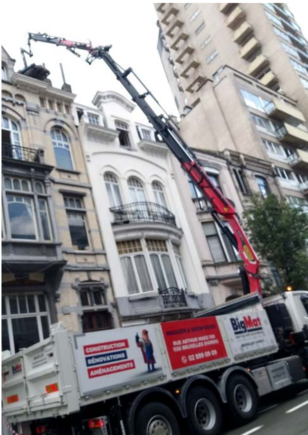
POSE DE CHEVALET POUR CHASSIS
